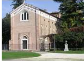
Вид с фасада
