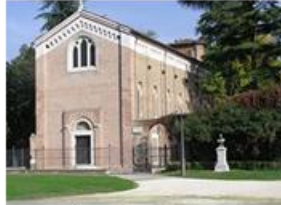
Вид с фасада
